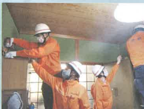
家具転倒防止金具取り付け作業
