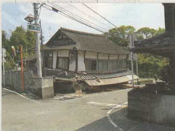
1階が押しつぶされた住宅
