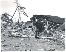
伊勢湾台風による桶町の被害(古崎地区)
