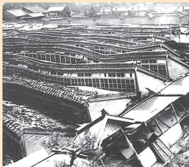
屋根がうねるように倒壊した網劔製鋼の工場(富田)
