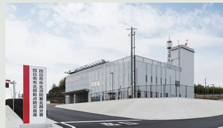
写真：北部拠点防災倉庫（外観）
