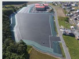
写真：総合防災拠点
