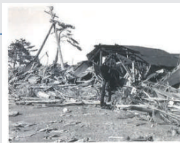
伊勢湾台風による楠町の被害 (吉崎地区)
