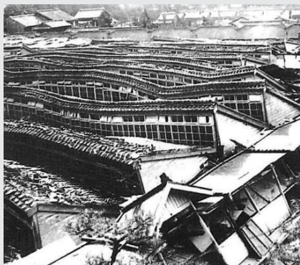
屋根がうねるように倒壊した網助製網の工場(富田)
